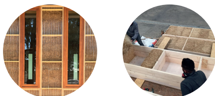
Caisson de remplissage préfabriqué, isolation en paille et revêtement en polycarbonate (Pré-fabrique de l'innovation, Z-Architecture, Villeurbanne)
