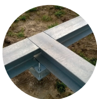
Longrine en poutrelles métalliques surélevées du sol posées sur des pieux vissés (Maison de la Lainière, Carlos Arroyo, Lille)
