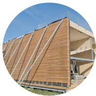
Mur porteur préfabriqué en bois (Maison de la Lainière, Carlos Arroyo, Lille)
