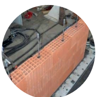
Appareillage de briques précontraintes, pose sèche et réversible (DEMODULOR)
